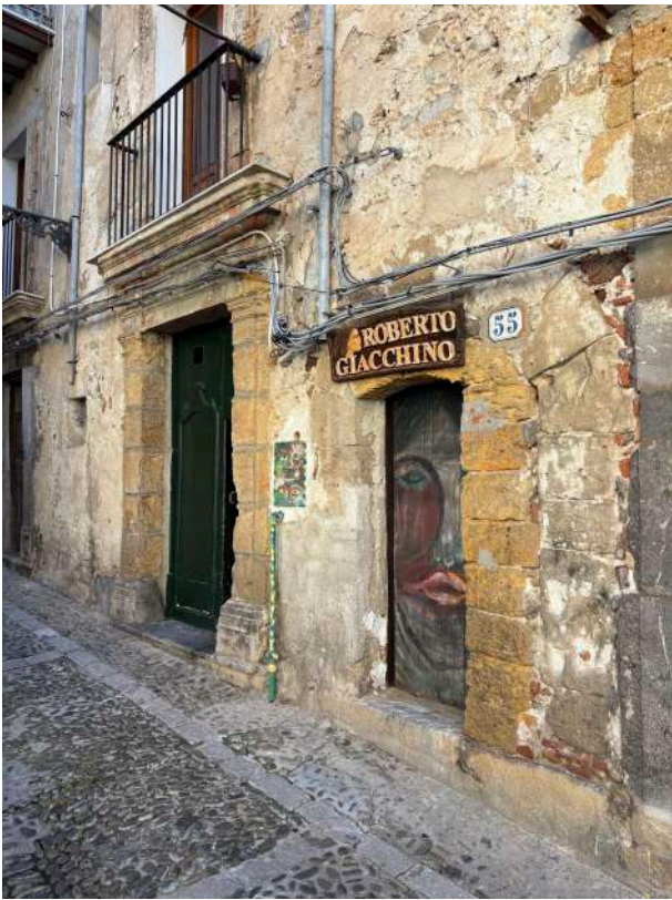
Ingresso edificio su via XXV Novembre n.53
